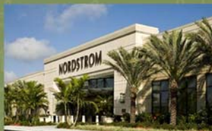
Aventura Mall- Nordstrom Expansion Aventura, FL
